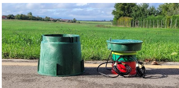
46. ábra: Kerékpárút burkolatába frissen telepített indukciós hurok és a föld alatt elrejtett elektronika (forrás: Eco-Counter)
