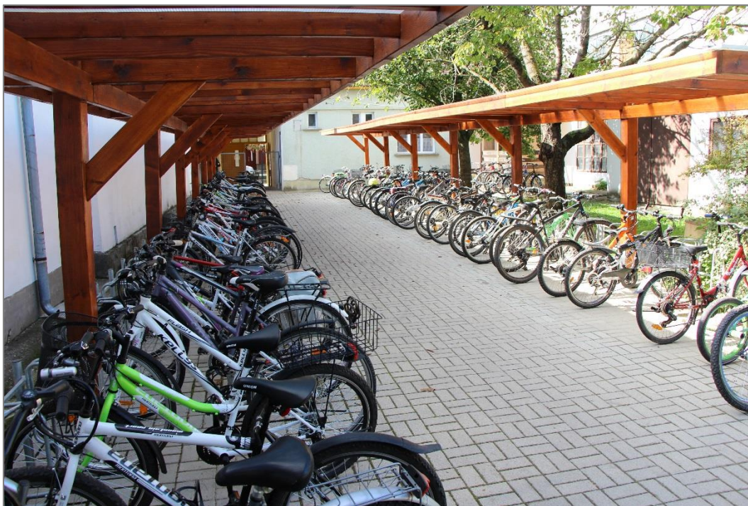
45. ábra: Iskolai kerékpártárolás (Bóly)
